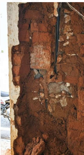
Figura 03 – Alvenaria de adobe exposta, com eletroduto embutido e remendos com blocos cimentícios
